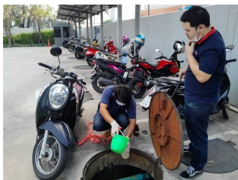
ภาพที่ 3-2 เก็บตัวอย่างคุณภาพน้ำทิ้งบริเวณน้ำจากบ่อพักน้ำสุดท้ายก่อนระบายออกระบบระบายน้ำทิ้งสาธารณะ
